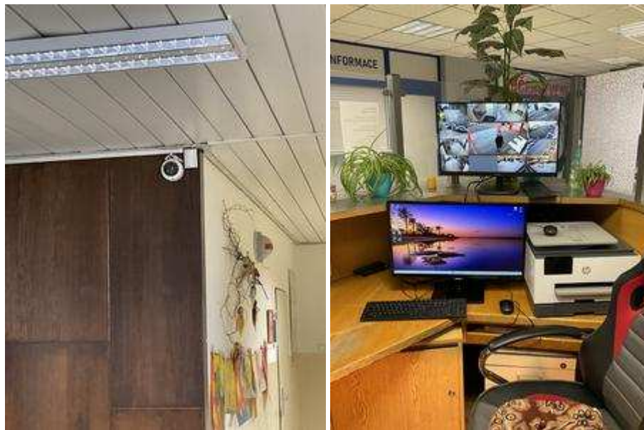
Obrázek 5 - CCTV na chodbách s výstupem na monitor recepce
